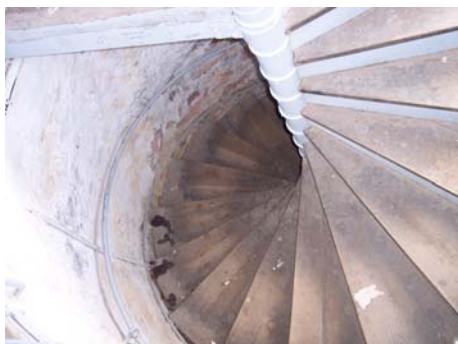
Bild 3 Wendeltreppe im Turminneren
